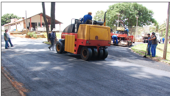
Recape feito no Clube de Campo foi uma das maiores obras realizadas
