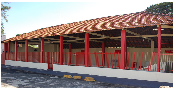
Campo de bocha teve telhado trocado e recebeu ventiladores
